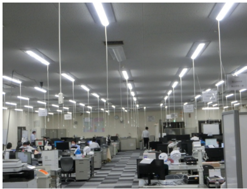
照明に個別スイッチを設置した事務所
