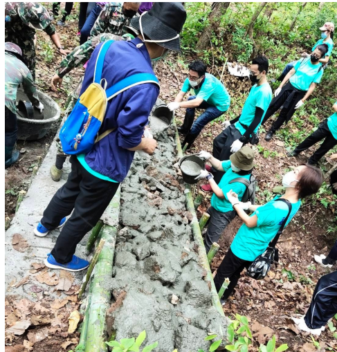
堰の設置作業
