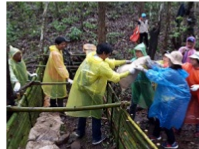
堰堤作り作業風景
