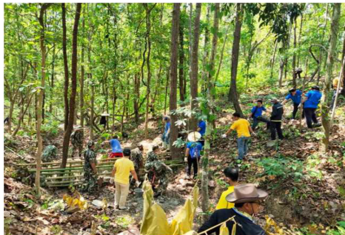
堰てい建設作業
