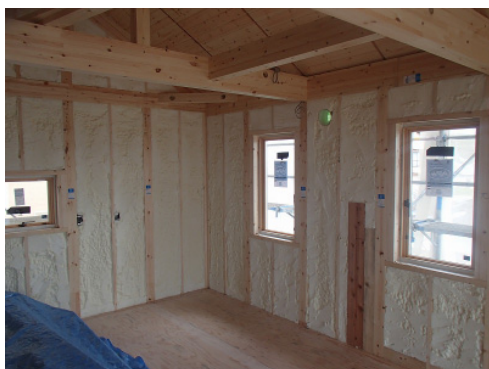
現場スプレー発泡による住宅断熱工事
