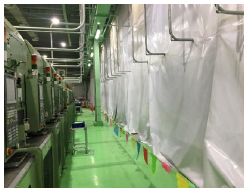
断熱シート設置
