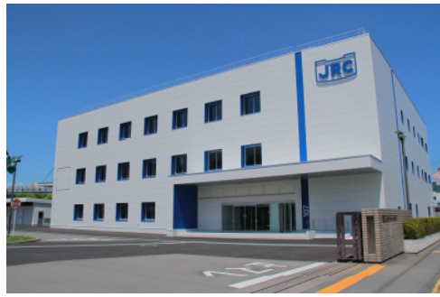
上田日本無線 本社工場 事務棟
