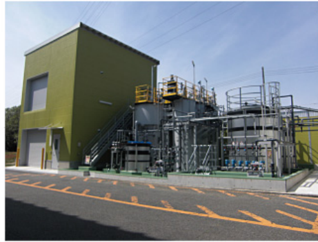
高度フッ素処理設備（再生回数適正化）
