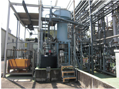
旧 フッ素処理設備
