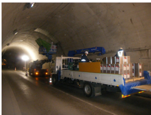
トンネル背面空洞補修工事
