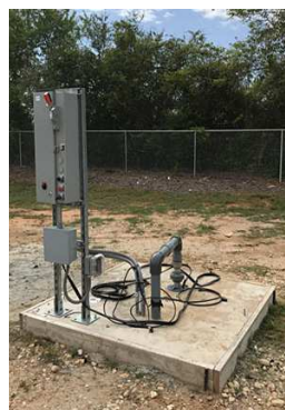
新設した井戸
