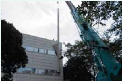
ボイラー煙突撤去工事
