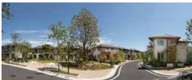
「川越ココロマチ」分譲地（川越事業所跡地）
