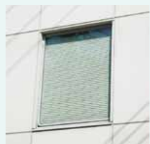
遮光フィルムを貼った窓
