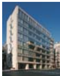
新日本無線(株)の東京本社
