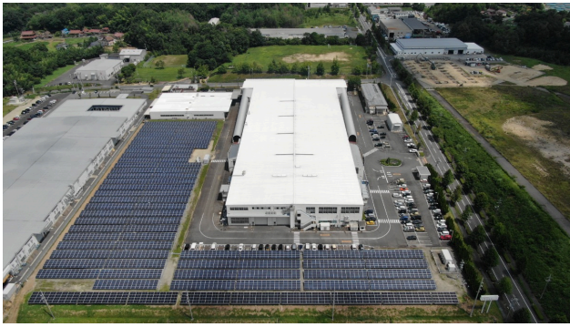
自家消費型太陽光発電設備
