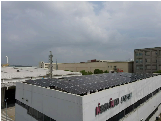
新たに設置した太陽光発電設備
