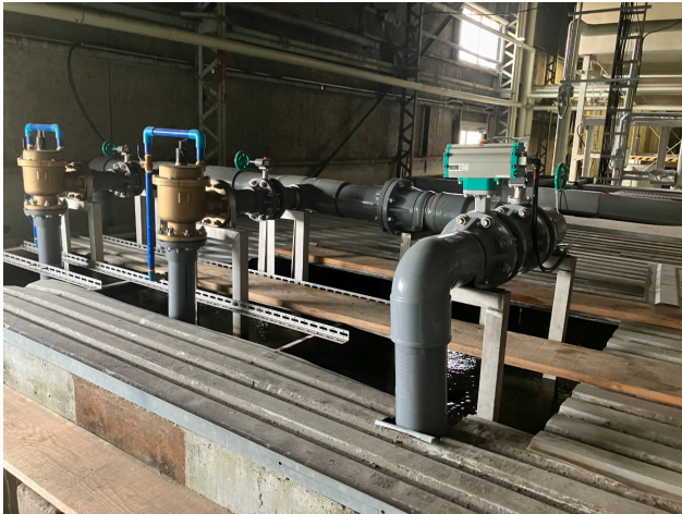
水位監視センサー
