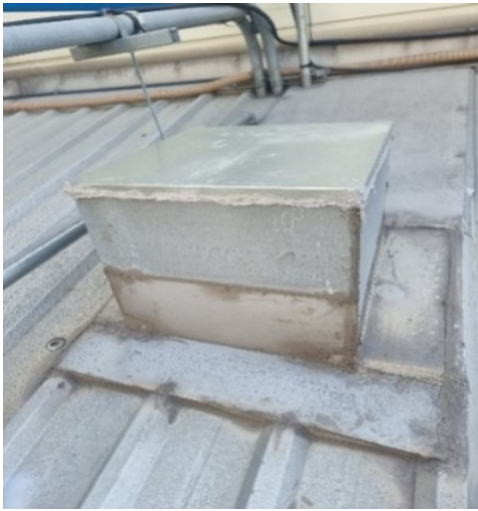
不要ダクトの撤去
