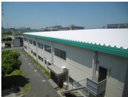
セラミック系遮熱塗料による塗装
