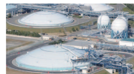
Onshore LNG terminal
