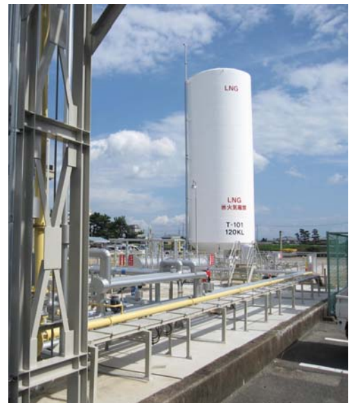
LNG satellite facility
