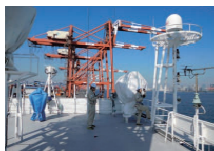
海上機器製品の稼働状態点検
