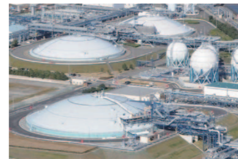
陸上LNG基地
