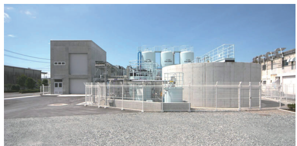
給排水処理設備 (左奥が排水処理設備、右が給水処理設備)
