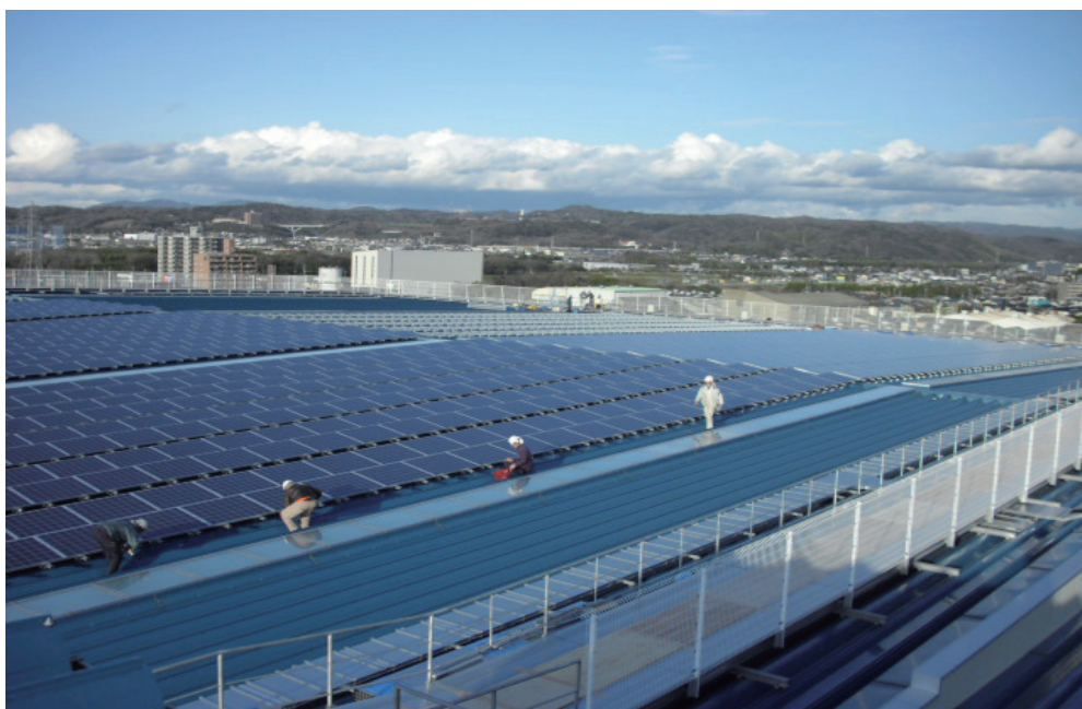
日清紡メカトロニクス(株)美合工機事業所に設置した太陽電池パネル
