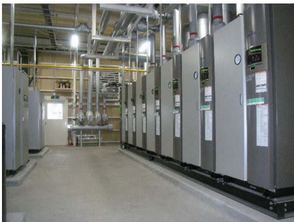
都市ガスボイラー
