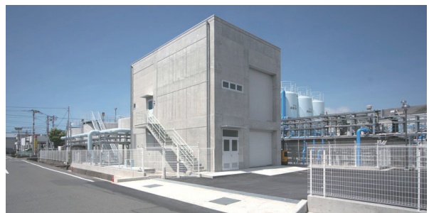
排水処理設備 (スクリープレスは建物内)
