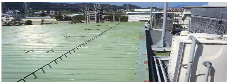
屋根への散水による暑熱対策
