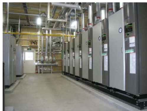
新設した都市ガスボイラー
